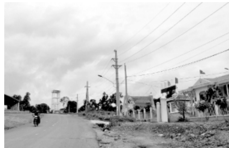
Đường dây cấp điện cho tỉnh Rattanakiri qua Cửa khẩu Quốc tế Lệ Thanh. Ảnh: K.N.B
