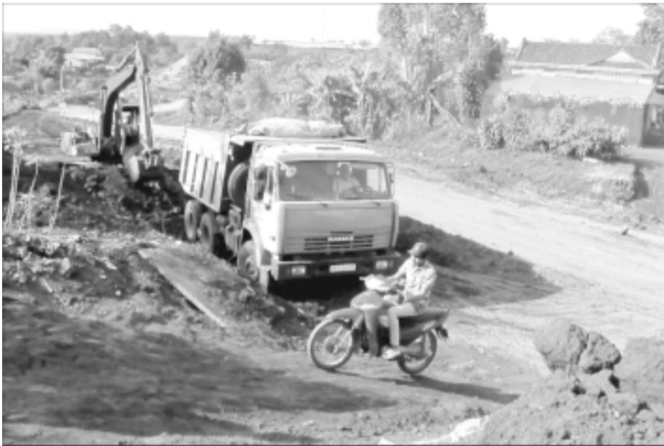
Các đơn vị đẩy mạnh tiến độ thi công công trình.
