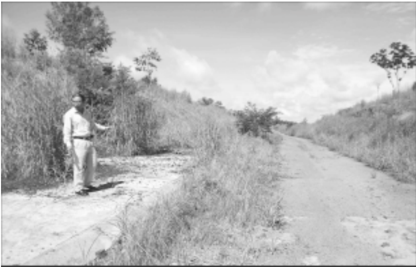
Một đoạn công trình đã làm vĩa hè để cỏ mọc.
