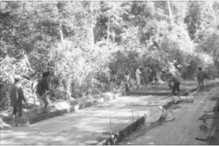
Thi công xây dựng đường liên xã Đak Sơ Mei-Hà Đông (huyện Đak Đoa). Ảnh: S.C
