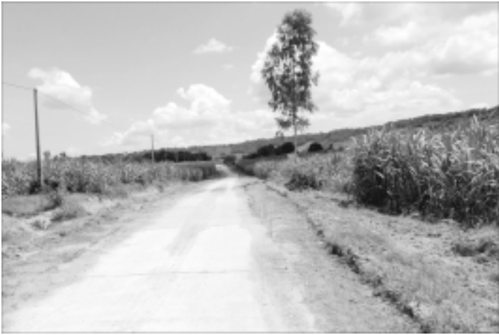
Đường vào Yang Nam đã được bê tông hóa.
