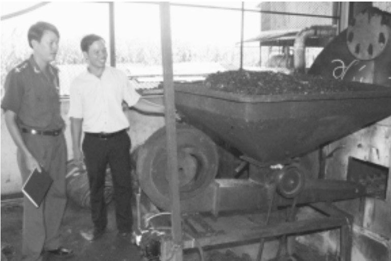
Kiểm tra công tác phòng cháy tại Nhà máy Điều Ayun Pa.
