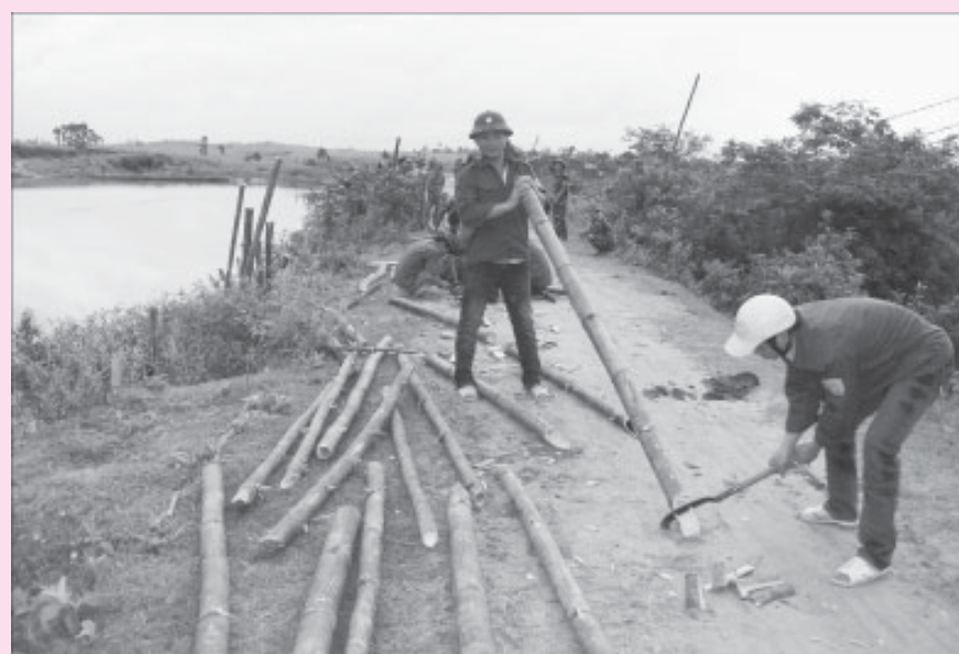
Chuẩn bị vật liệu để gia cố bờ đập tại xã Thành An. Ảnh: L.N
