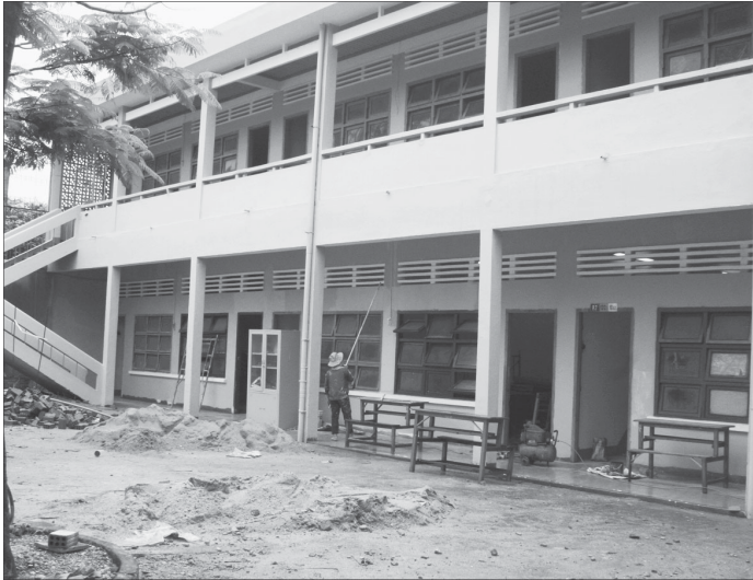
Cơ sở vật chất Trường THPT Phan Bội Châu-TP. Pleiku đang chạy đua cùng thời gian, thời tiết để đảm bảo hoàn thành việc sửa chữa đúng tiến độ, kịp phục vụ cho năm học mới. Ảnh: P.D
