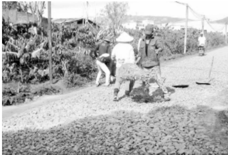
Làm đường giao thông nông thôn ở xã Biển Hồ (TP. Pleiku). Ảnh: H.D
