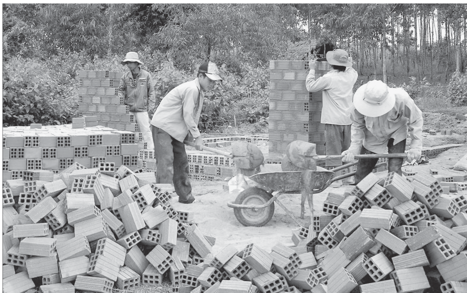
Thi công xây dựng nhà thuộc Chương trình 167.
