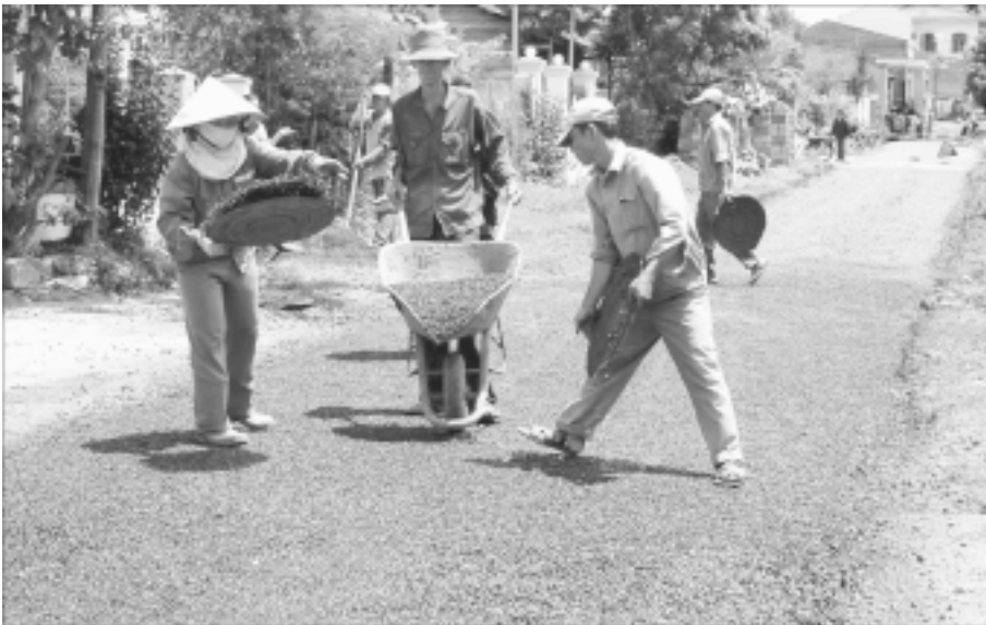
Làm đường giao thông nông thôn.
