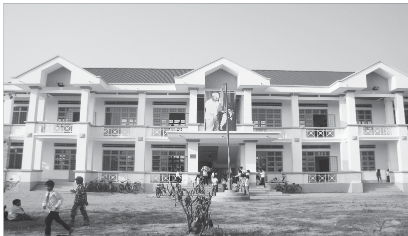
Khu nhà hai tầng với 8 phòng học được xây dựng khang trang.
